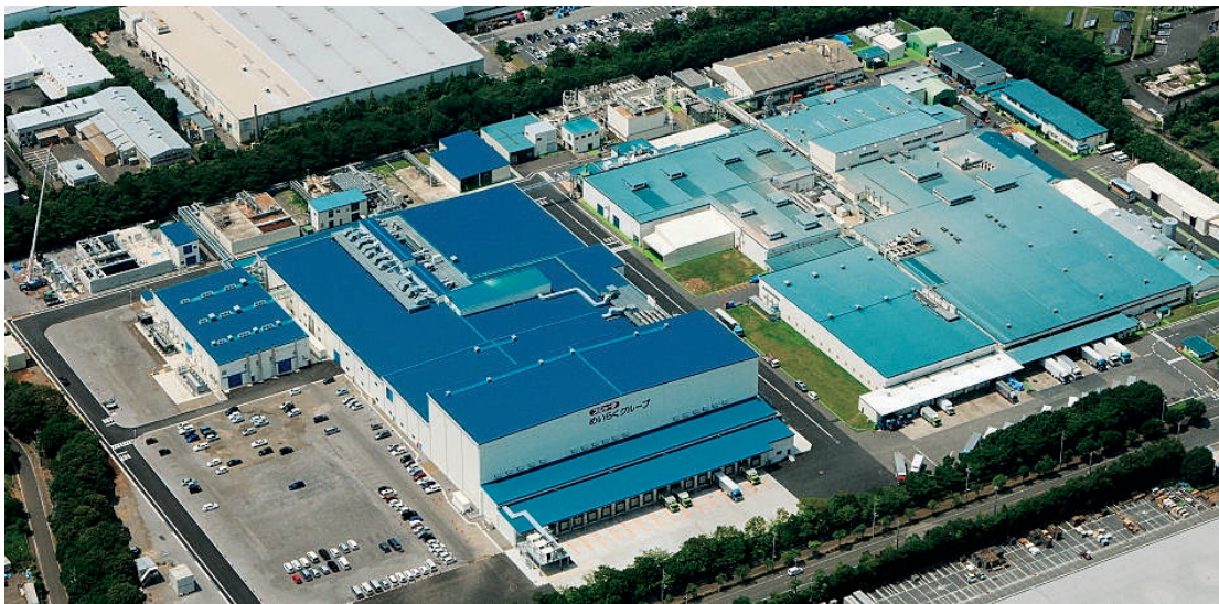
工事名：平成23年東京めいらく千葉工場増築工事（千葉県） 発注者：株式会社東京めいらく
