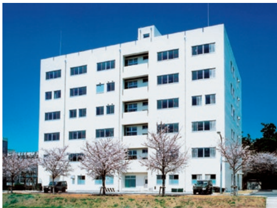
工事名：習志野（20）庁舎新設建築その他工事（千葉県） 発注者：北関東防衛局
