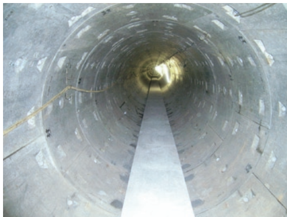
工事名：一般国道45号仙台東部（原町）共同溝工事（宮城県） 発注者：国土交通省東北地方整備局
