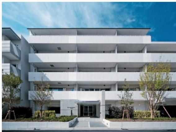
工事名：(仮称)世田谷区上野毛一丁目計画（東京都） 発注者：株式会社新日鉄都市開発、 三井不動産レジデンシャル株式会社
