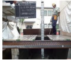
60m掘削・攪拌完了
