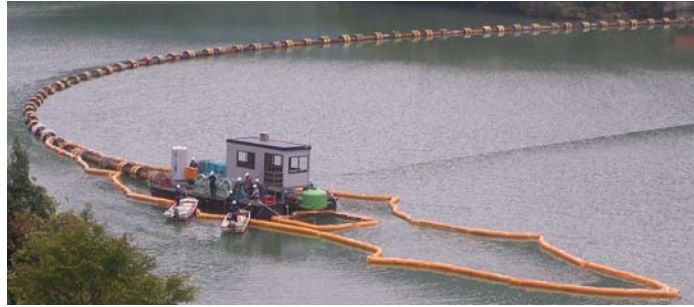
直径40cmの輸送管による土砂の湖内移動
