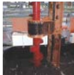
安定化促進実験の状況 (RP工法施工中の様子)
