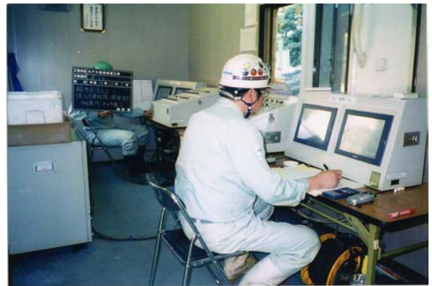
写真－3 注入流量・注入圧管理状況
