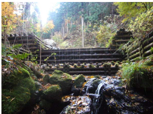
写真-2 木製治山ダム（京都府京都市）
