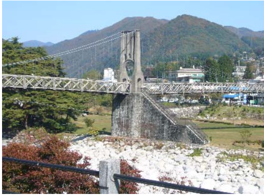
(a) 主塔部遠景
