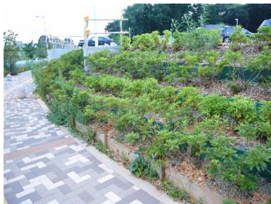
(a) のり面緑化工全景
