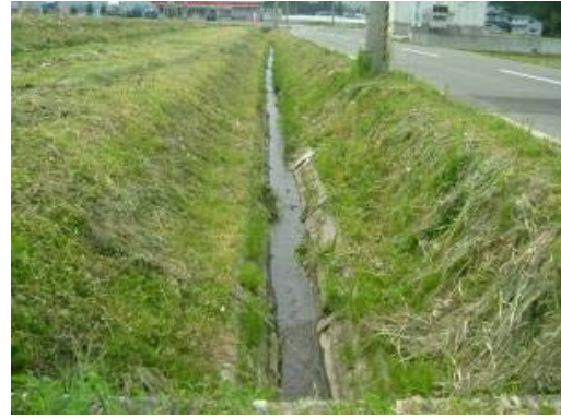
(b) 水路脇の腐朽している木杭
